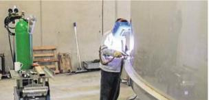
Von außen zeigt derzeit nur der Kran, dass die Arbeiten am neuen Hochbehälter voranschreiten. Er hält durch das Dach hindurch die am Ende 30 Tonnen schwere Tankkonstruktion. Im Inneren wachsen derzeit die beiden Wassertanks in die Höhe (unten, links). Über 46 Meter lang ist die Schweißnaht, die zwei Stahlbänder miteinander verbindet.
